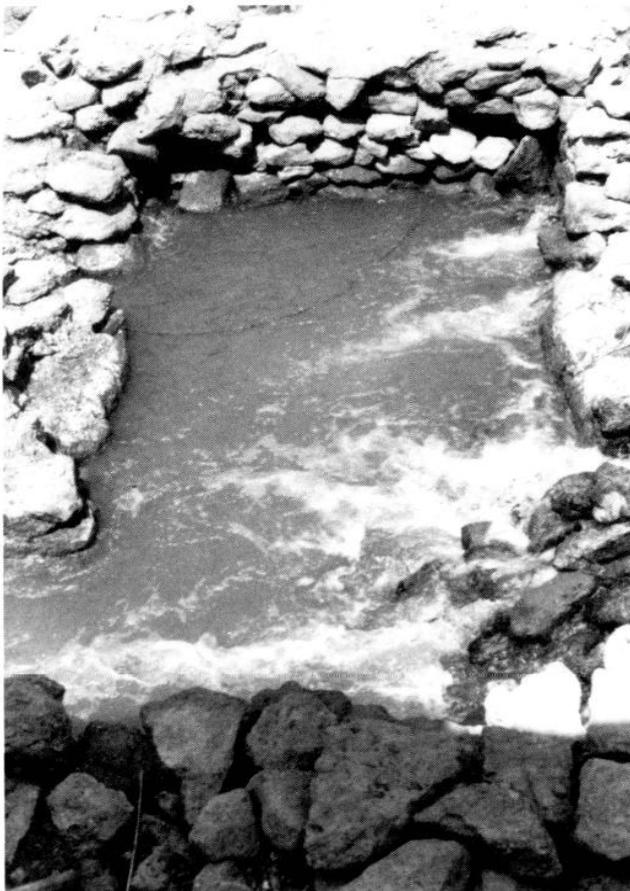
*Figure 22 : Espace réservé dans le barrage d'al-Masri, pour le mécanisme d'un moulin.*
