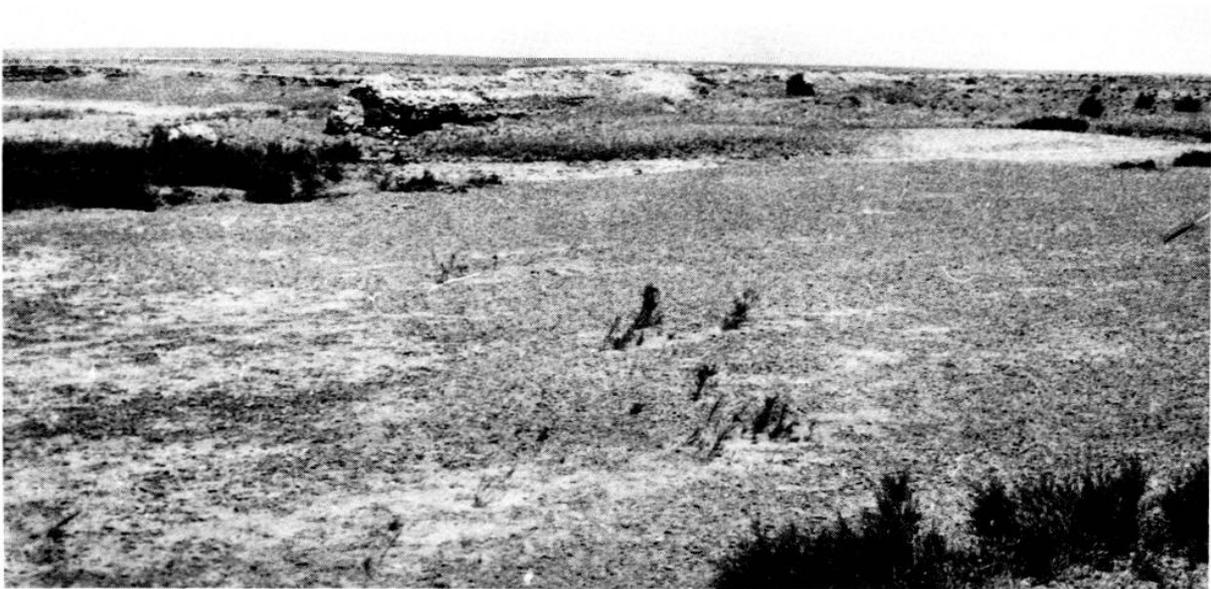
*Figure 60 : Le barrage du wadi as-Souab, vu de la rive droite ; à gauche de la photographie, la rupture de l'ouvrage.*
