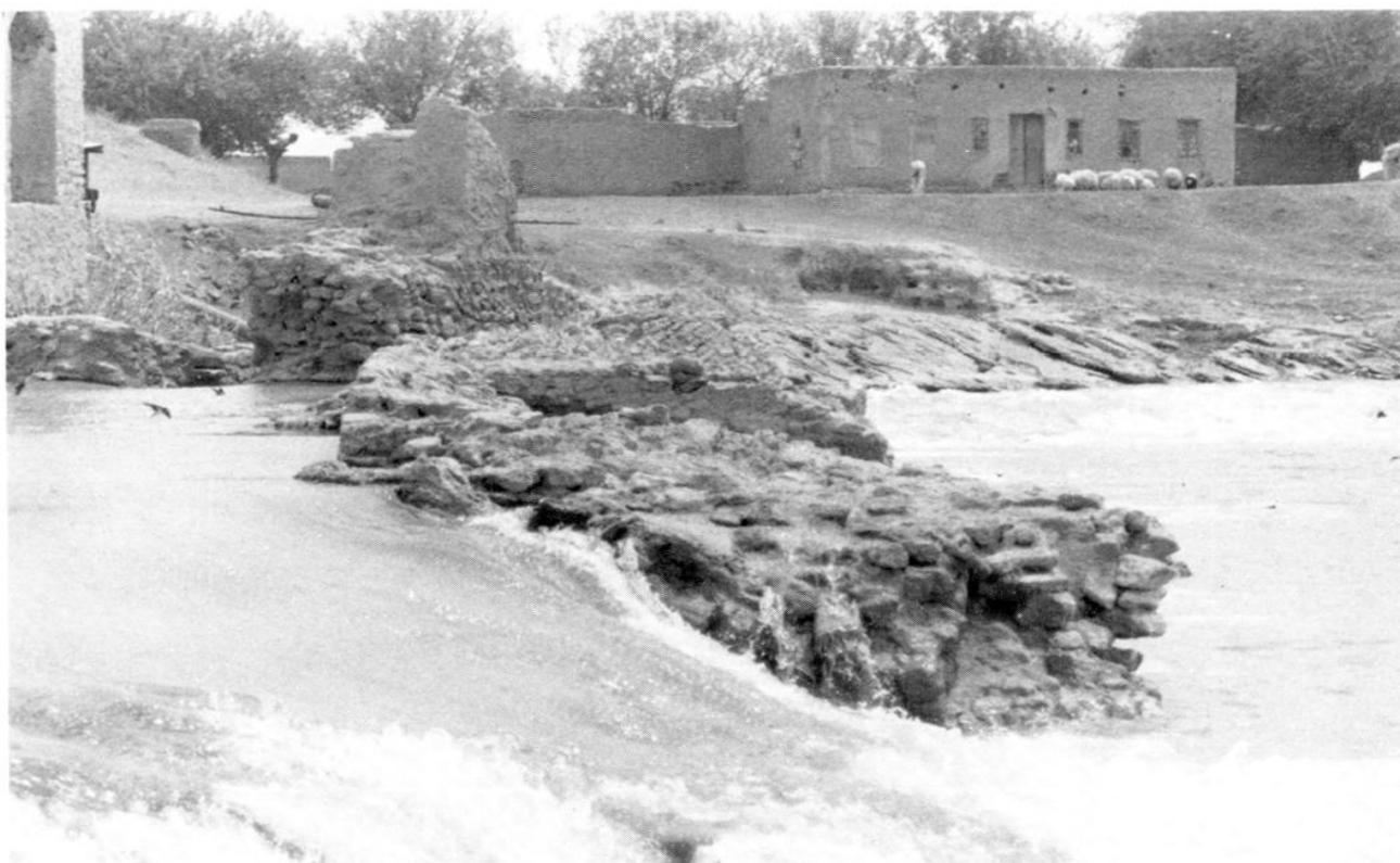
*Figure 18 : Barrage d'ar-Rashdi ; détail de l'appareillage, à la faveur d'une rupture de l'ouvrage.*
