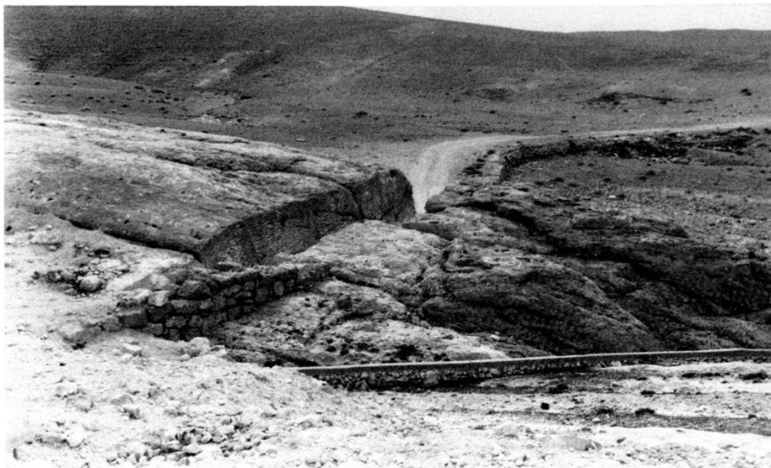
*Figure 52 : Le barrage amont de Khan al-Manqoura et la saignée du canal,
